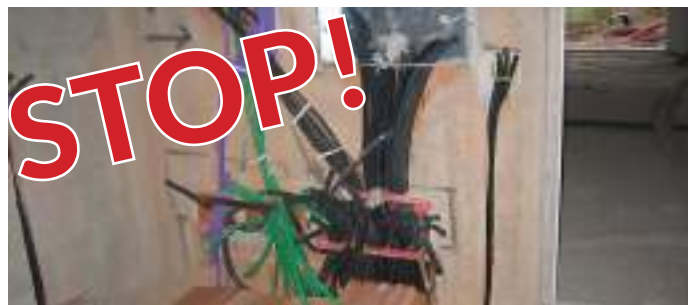
Per fare domotica aumentano sempre più le dimensioni dei quadri e scatole di derivazione.
