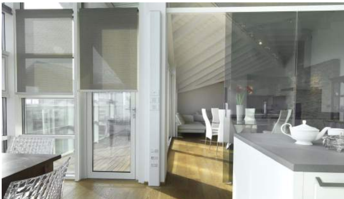
Columbus bianca abbinata ai pannelli della linea Click&Touch white e tutto perfettamente integrato con lo stile dell'abitazione. Qui gestisce l'illuminazione a Led dimmerizzabile, la temperatura di stanza, prese tv e sat, prese lan, prese elettriche e telefoniche, lampada di emergenza e salvavita. L'impianto elettrico è perimetrale, sempre ispezionabile, implementabile e coperto con finitura coordinata al parquet.
