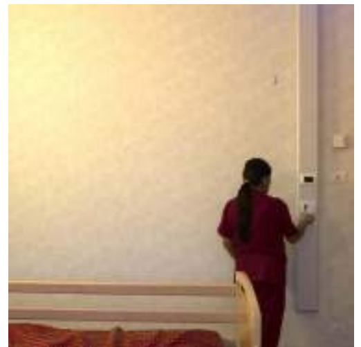
Columbus bianca abbinata ai pannelli della linea Click&Touch white per la gestione delle chiamate degenti, del controllo della temperatura, delle luci Led segna-passo oltre che della profumazione ambientale.
