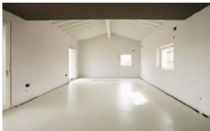
Questa è una casa con impianto perimetrale finito, riscaldamento a pavimento posizionato, copertura con resina terminata, pareti pitturate... ora basta arredare e per ultimo posizionare Colunbus!
